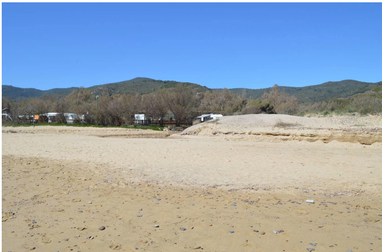
Foto 7 – Grande accumulo di sabbia, ghiaia e materiale piaggiato nel settore occidentale della spiaggia di Lacona, con funzione di “scorta” per l’inizio della stagione balneare. La localizzazione del sito di stoccaggio non è adeguata perché compromette la fascia antedunale e quella di duna stabilizzata.
